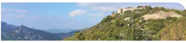
fort de Pipaudon
