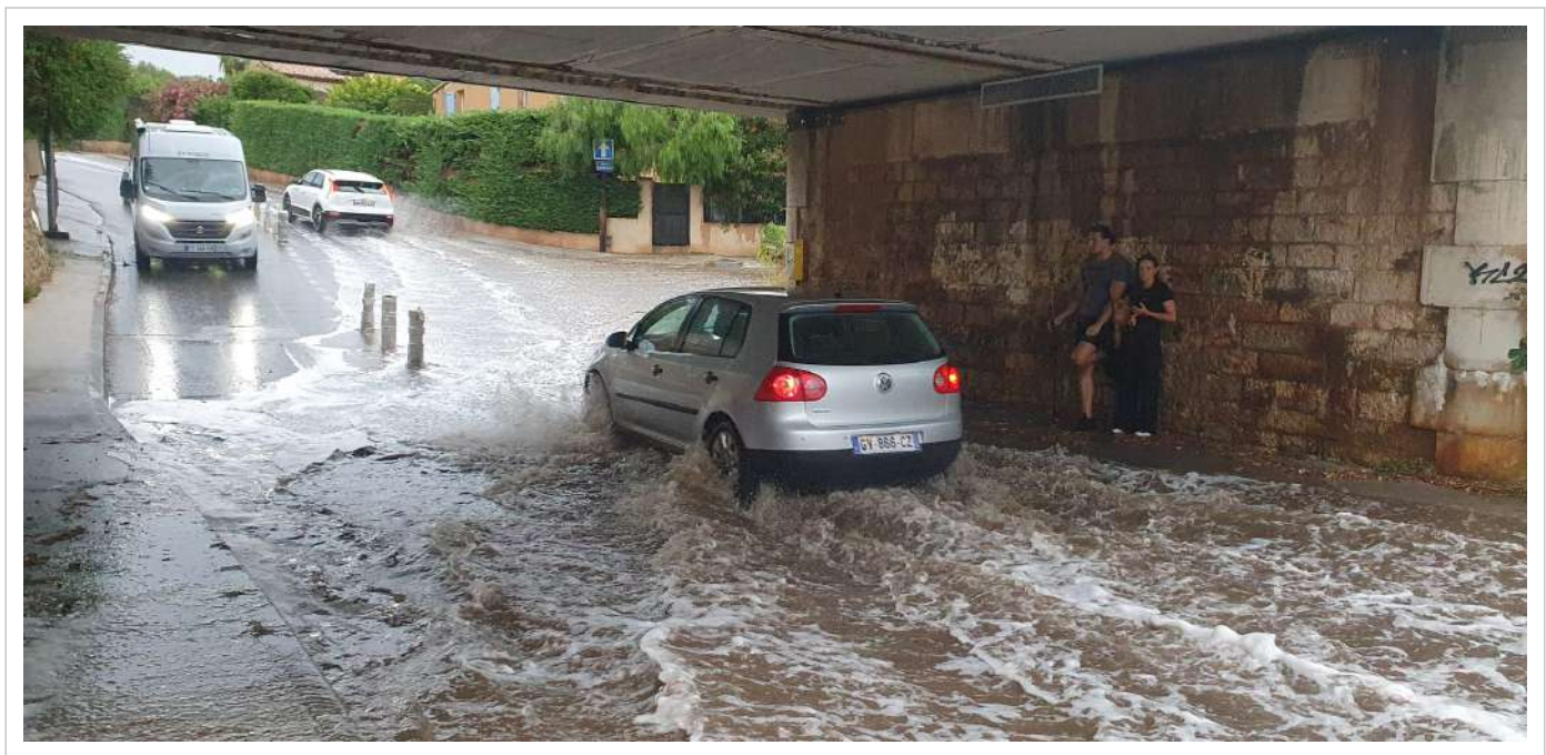
Photo 3 - Boulevard de Lorette (sous le pont SNCF), 15 août 2024
