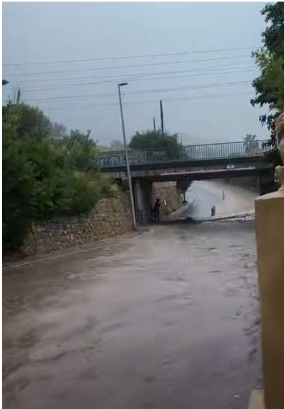
Photo 2 - Boulevard de Lorette (sous le pont SNCF), 24 janvier 2026
